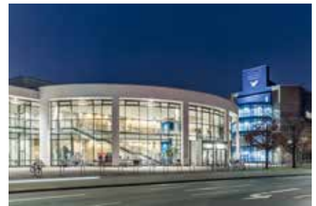
Hörsaalzentrum bei Nacht: Universität Oldenburg © Bild: Martin Remmers
